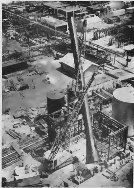
Un otro schoorsteen ta bai halto, esaki ta di 63 den refinaria. Dos grua grandi ta biza e schoorsteen na Cat Cracker.
